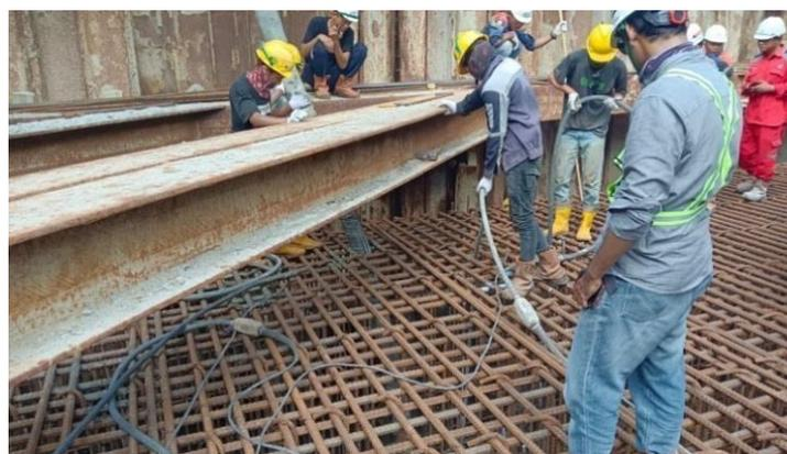
Gambar 2. Pengecoran *pilecap pier 1* jam 16.00 s/d 17.00 wita
