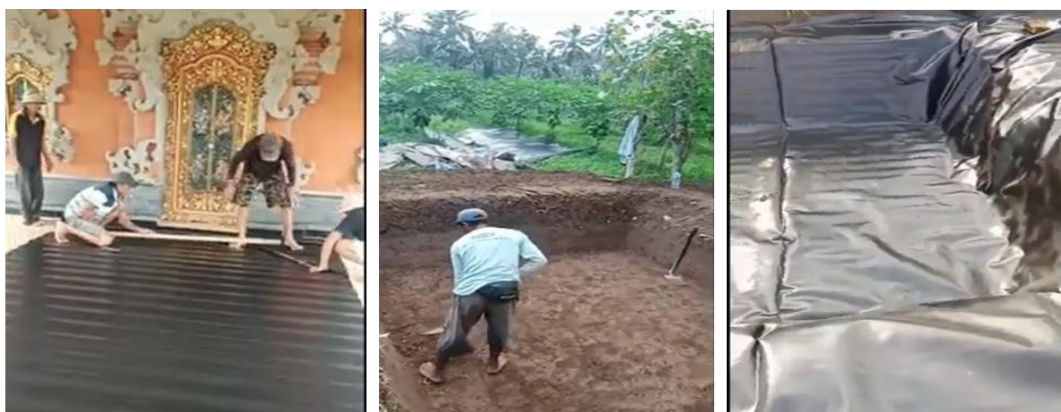
Gambar 7. Proses Pembuatan Cabang Pemanenan Air Di Subak Dari Bahan Geomembran
