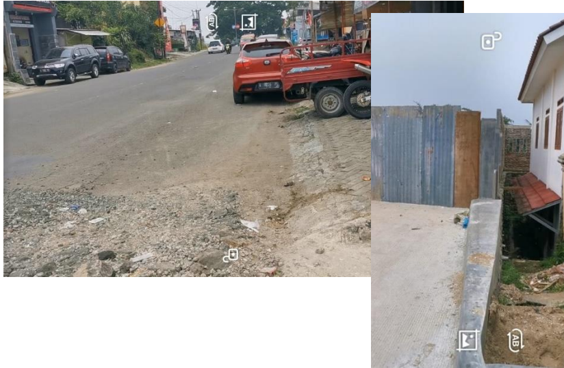
Gambar 3. Situasi dan kondisi jalan di depan proyek SPBU sebelah kiri
