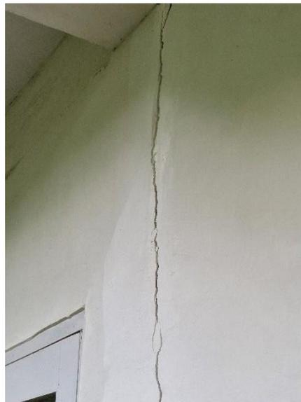
**Gambar 3 Salah satu kerusakan aristiktrual yang terjadi pada bangunan yang ada pada lereng tanpa penyelidikan tanah yang cukup**
