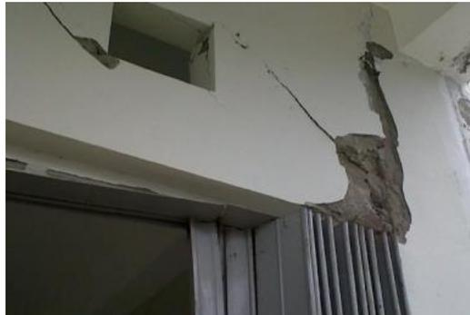
**Gambar 1. Kerusakan struktural join dan retak pada tembok**
