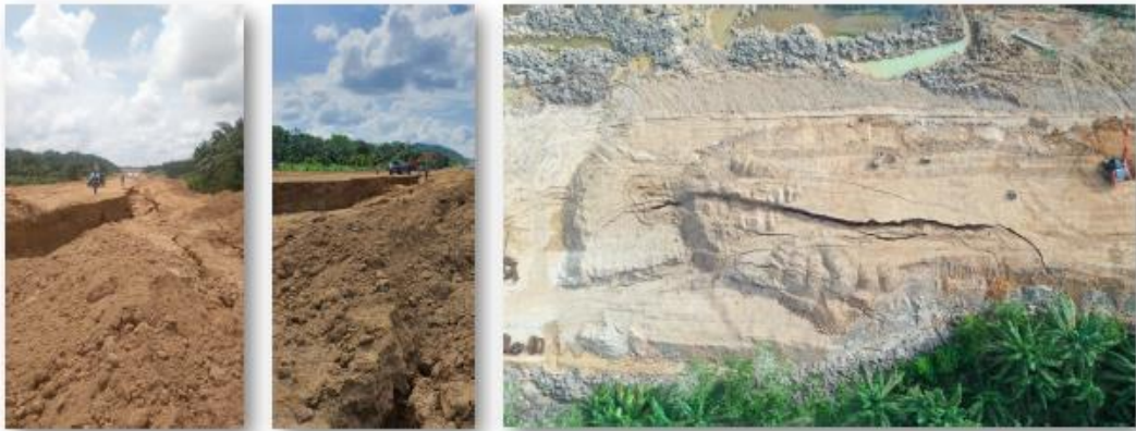
Gambar 11 Longsoran pada Badan Jalan
